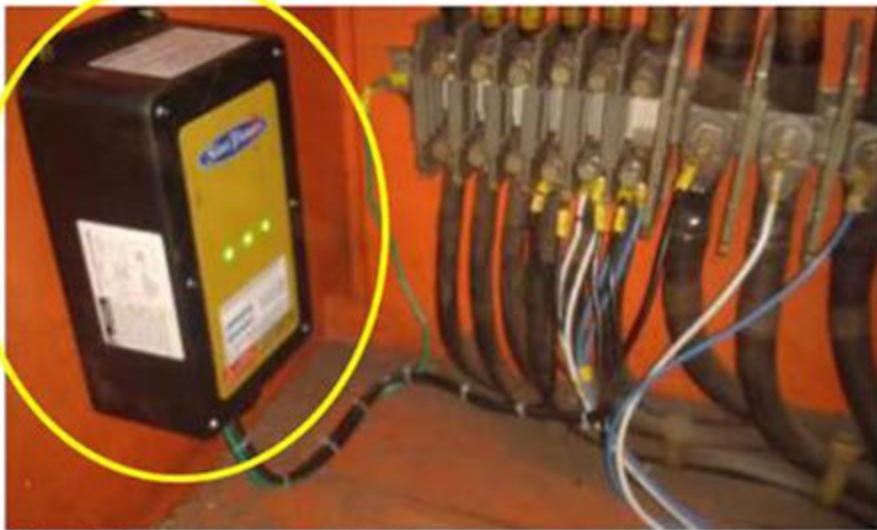
Painel: Retificar para Eletroímã;
